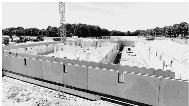
Der Kubus besteht überwiegend aus Beton-Fertigteilen. FOTO: KREIS VIERSEN
