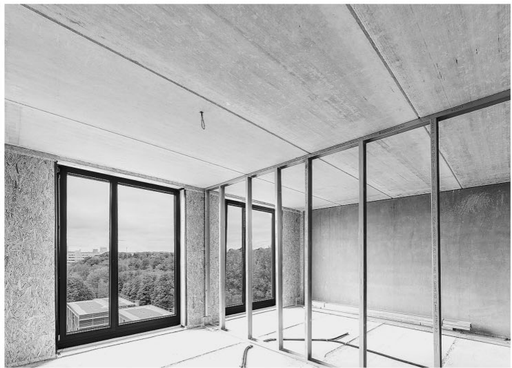
Blick in die Apartments der Studierenden in Wuppertal: Große, deckenhohe Fensterflächen lassen „innen“ mit „außen“ verschmelzen, die langen Spannweiten der Spannbeton-Fertigdecken ermöglichen anpassungsfähige Grundrisse. FOTO: THOMAS BOCIAN
