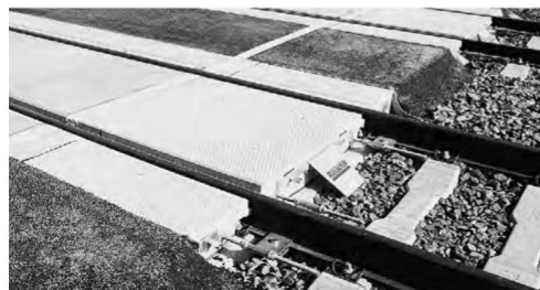
In Bautzen wurde das BETOCross Bahnübergangssystem verbaut. FOTO: RAILBETON
