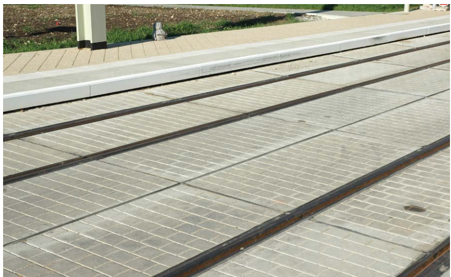
Gleiseindeckung mit Pflasterstruktur, Zwickau, Marchlewskistraße
