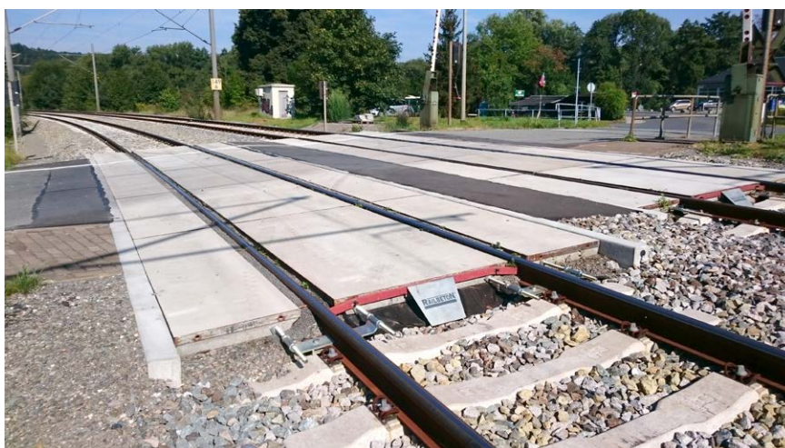
Gleisüberwege (GÜP) System Chemnitz, Blankenstein (Thüringen)
