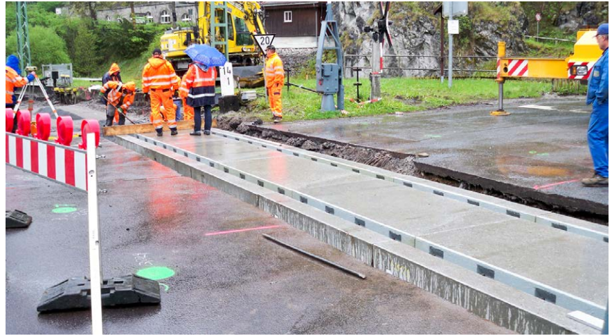
Verlegung Gleistragplatten, Rübeland
