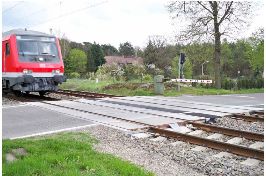
Gleisüberweg GÜP, Krielow
