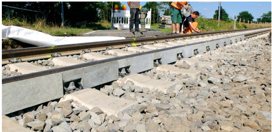
Schienenkammerstein bei Mittelplattensystem
