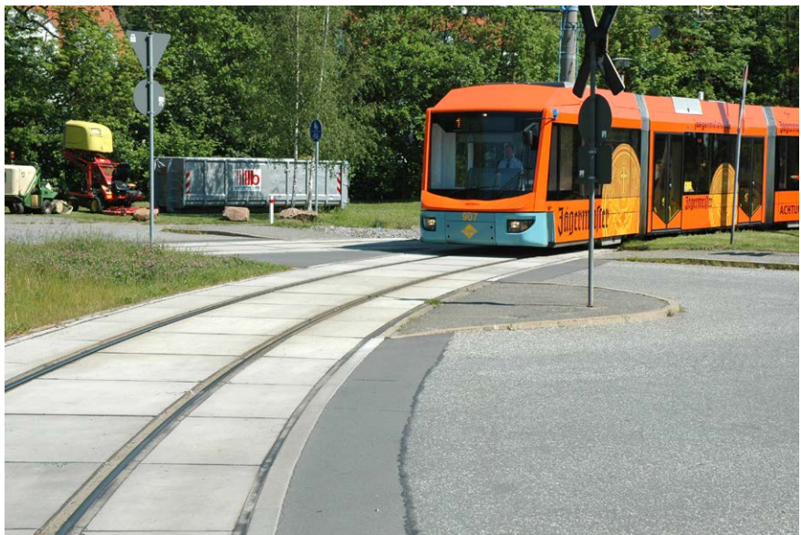
Gleiseindeckung mit Jutestruktur, Chemnitz, Popowstraße
