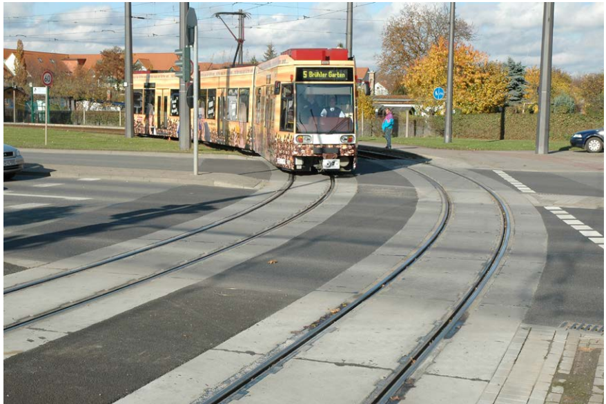
Gleistragplatten RAILcross® Ultra im Bogen, Erfurt
