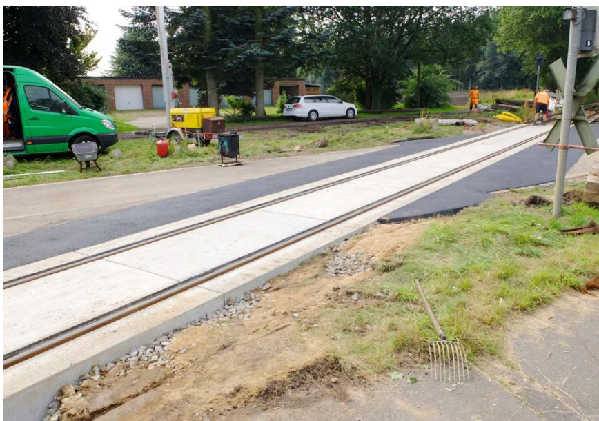
Gleistragplatten mit Schrägüberführung, Albersdorf
