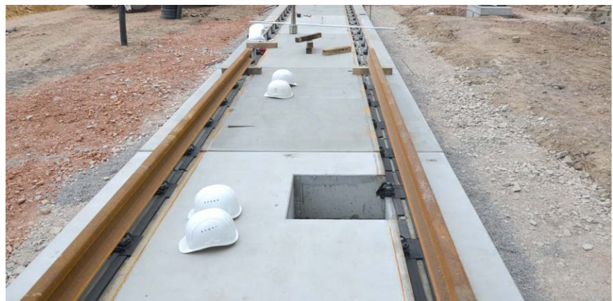
Einbau Gleistragplatte mit Aussparung, Chemnitz VW Werk
