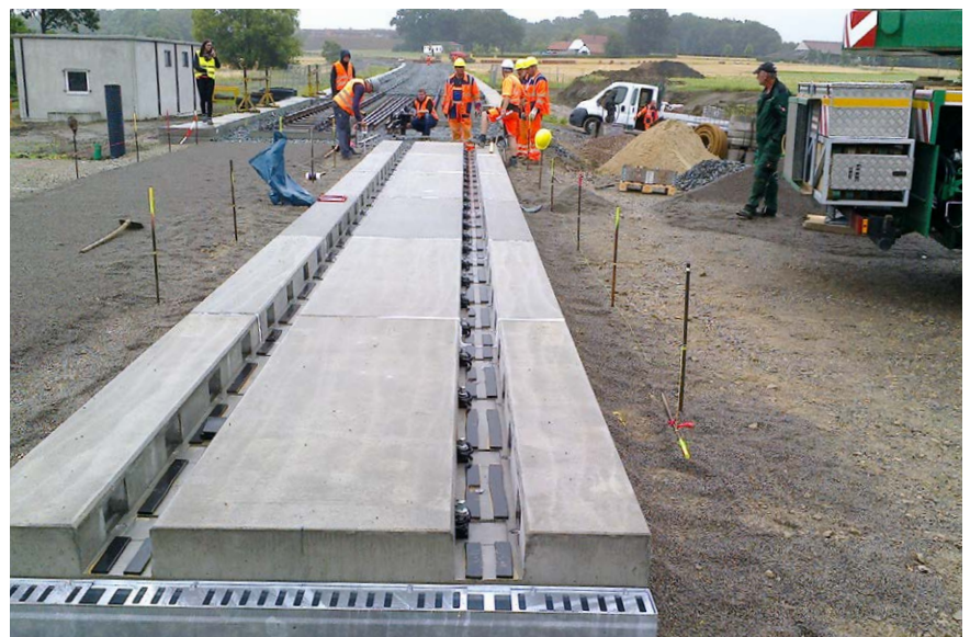
Verlegung Gleistragplatten mit stirnsei- tiger Entwässerung, Bielefeld
