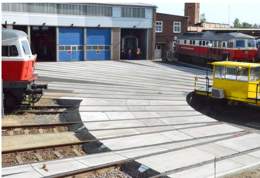
Weicheneindeckung und Passplatten, Drehscheibe Cottbus
