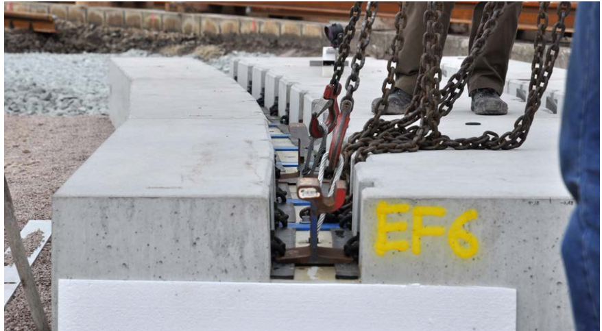
Verlegung von trapezförmigen Gleistragplatten RAILcross® Ultra im Bogen, Erfurt
