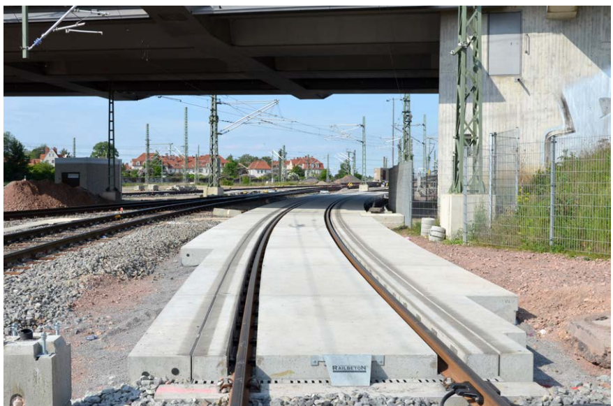
Gleistragplatte RAILcross® Pro im Bogen mit stirnseitiger Entwässerung und Auflaufkeil, Halle
