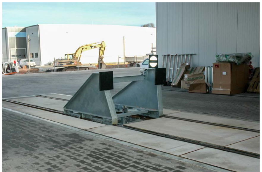
Gleisüberweg GÜP, mit Bremsprellbock, Chemnitz
