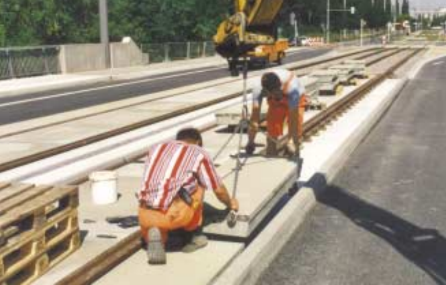
Leipziger Verkehrsbetriebe, covering of bridge Zwickauer Straße
