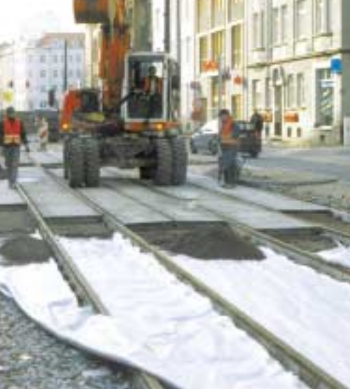
Erfurter Verkehrsbetriebe, track slab laying
