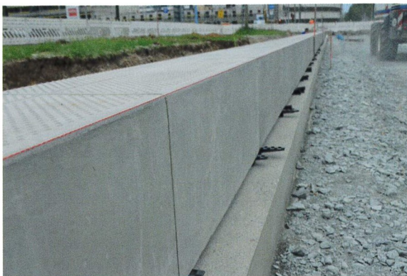
Abb. 1: Variobord-Einbau in der Augustusburger Straße ...
