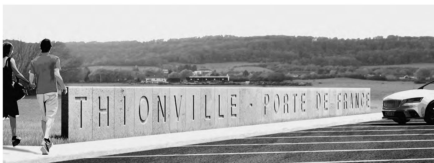
An einem Rastplatz an der französischen Autobahn A31 wird in Kürze eine Lärmschutzwand aufgestellt, deren Betonfertigteile aus recycelten Gesteinskörnungen bestehen. FOTO UND ABB.: SYSPRO-GRUPPE BETONBAUTEILE E. V.; BETON-BETZ
