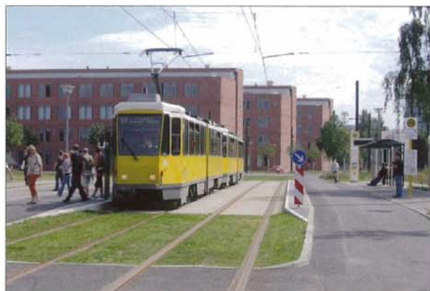
Endstelle Karl-Ziegler-Straße mit Tw 6105+6192 an den überfahbaren Haltestellenkaps neben einem Solarpark. Auf dem im Hintergrund sichtbaren Rasenbahnkörperabschnitt in der Max-Born-Straße sind die Vignolschienen 49E1 auf 450 m Länge zur Körperschallminderung zusätzlich mit elastischen Profilen als „Ortec-Flüsterschienen“ ummantelt.
